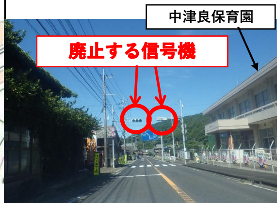
廃止箇所写真
