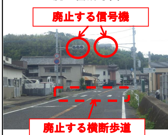
廃止箇所写真
