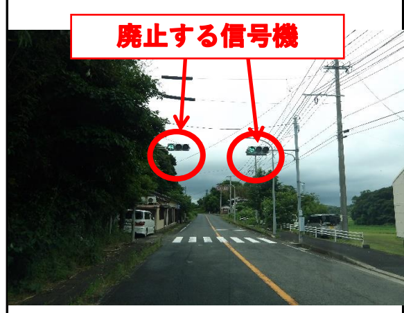
廃止箇所写真
