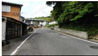
①阿翁免 道幅が狭いが、車の通りが多く、見通しも悪い。
