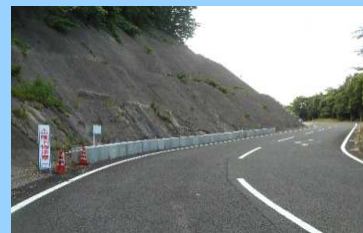
③調川町平尾地区入口 落石に注意。
