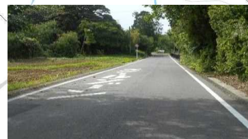
④調川町下免から上免に至る市道 車の通行が多く、歩道と車道の区 別がないので、要注意。
