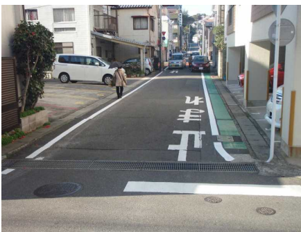
【路側帯のカラー舗装及び路側帯拡幅】
